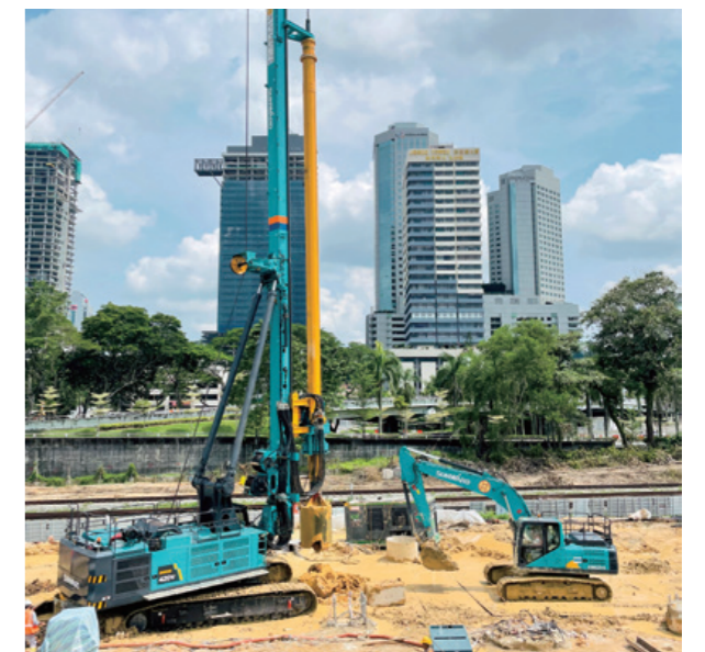
山河智能旋挖钻机集群助建新加坡一柔佛轻轨
