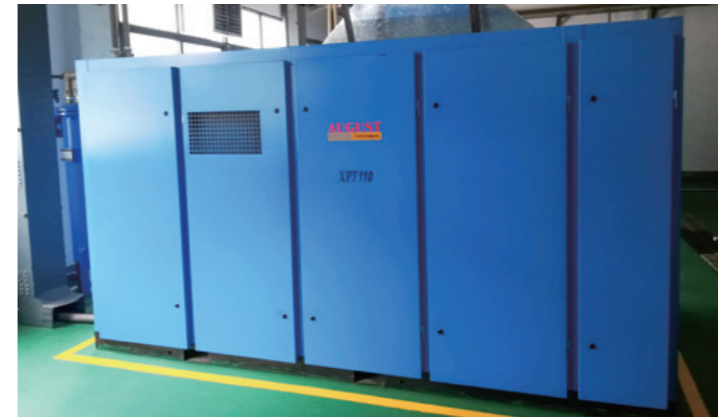
山河工业城采用双级压缩永磁变频空压机组，节能率 20% 以上，年节电 40 万千瓦时，减少碳排放 196 吨
