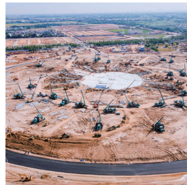
山河智能批量静压桩机助建东南亚面积最大的会展中心—越南CO LOA 国家会展中心
